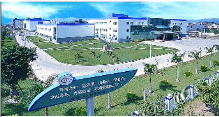
Hongfa (oben) gehört national wie international zu den Spitzenproduzenten von Relais – nicht zuletzt dank der durchgängig eingesetzten ALLROUNDER Spritzgießtechnik (links unten).
