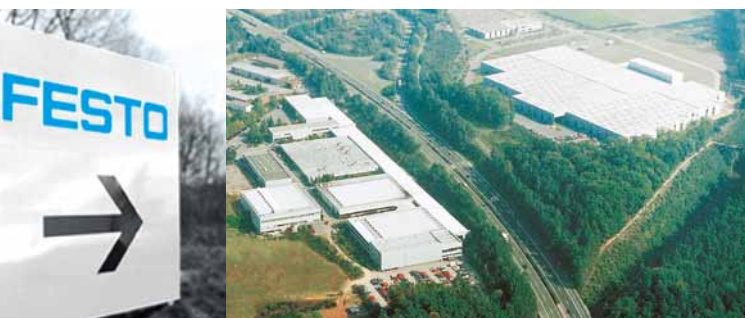
Ecco di che cosa si tratta: luogo di produzione della Festo in St. Ingbert-Rohrbach, nella Saar
