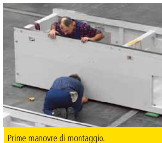
Prime manovre di montaggio.
