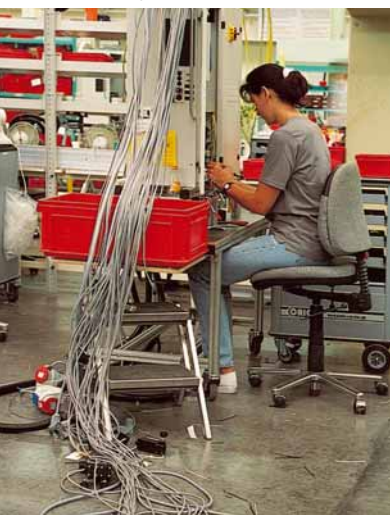
Montage des armoires de commande
