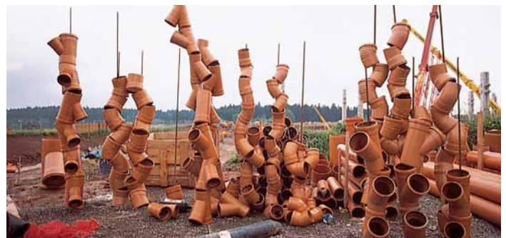
Kunst am Bau: Die verschiedensten Rohre werden vorsortiert.
