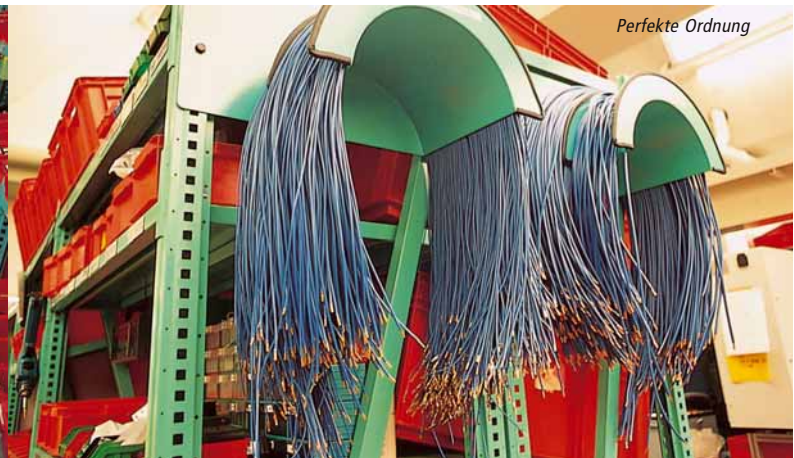
Montage der Starkstromkomponenten
