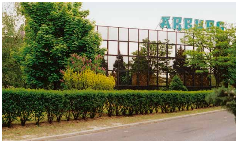
La filiale ARBURG à Aulnay-sous-Bois
