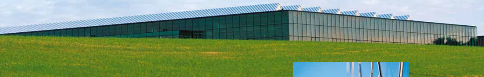
Le bâtiment est déjà là, mais les travaux de finition d'ARBURG II ne sont pas encore achevés.
