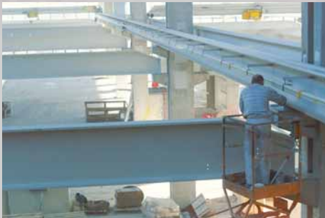
Arbeiten in luftiger Höhe: Hebebühnen waren überall im Einsatz, um wie hier die Krantraversen dort zu setzen, wo sie später gebraucht werden.
