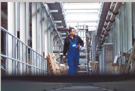
Letzter Schliff: Die Handwerker wissen genau, wo es noch fehlt. Und jeder trägt dazu bei, dass die Arbeiten zügig weitergehen.
